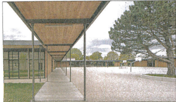
Die offene, überdachte Pergola.
